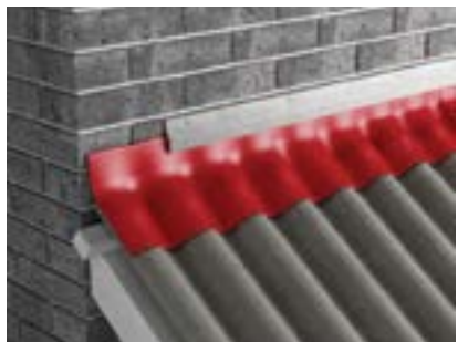
44 att. Jumta un sienas saskares vietas apdare.
