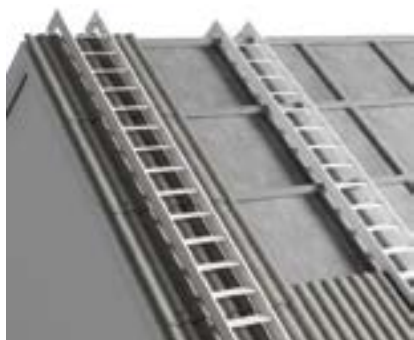
17. att. Piemērs, kā pakarina kāpnes, montējot viļņotās jumta loksnes.
